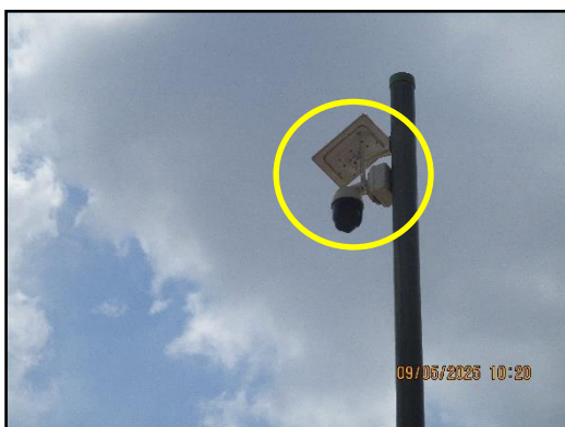
ภาพที่ 2.27 การติดตั้งกล้องวงจรปิดภายในพื้นที่โครงการ
